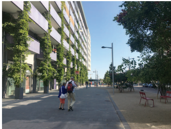
Abb. 3: Seestadt Aspern. Straßenraum mit Mischprinzip (eigene Darstellung).
